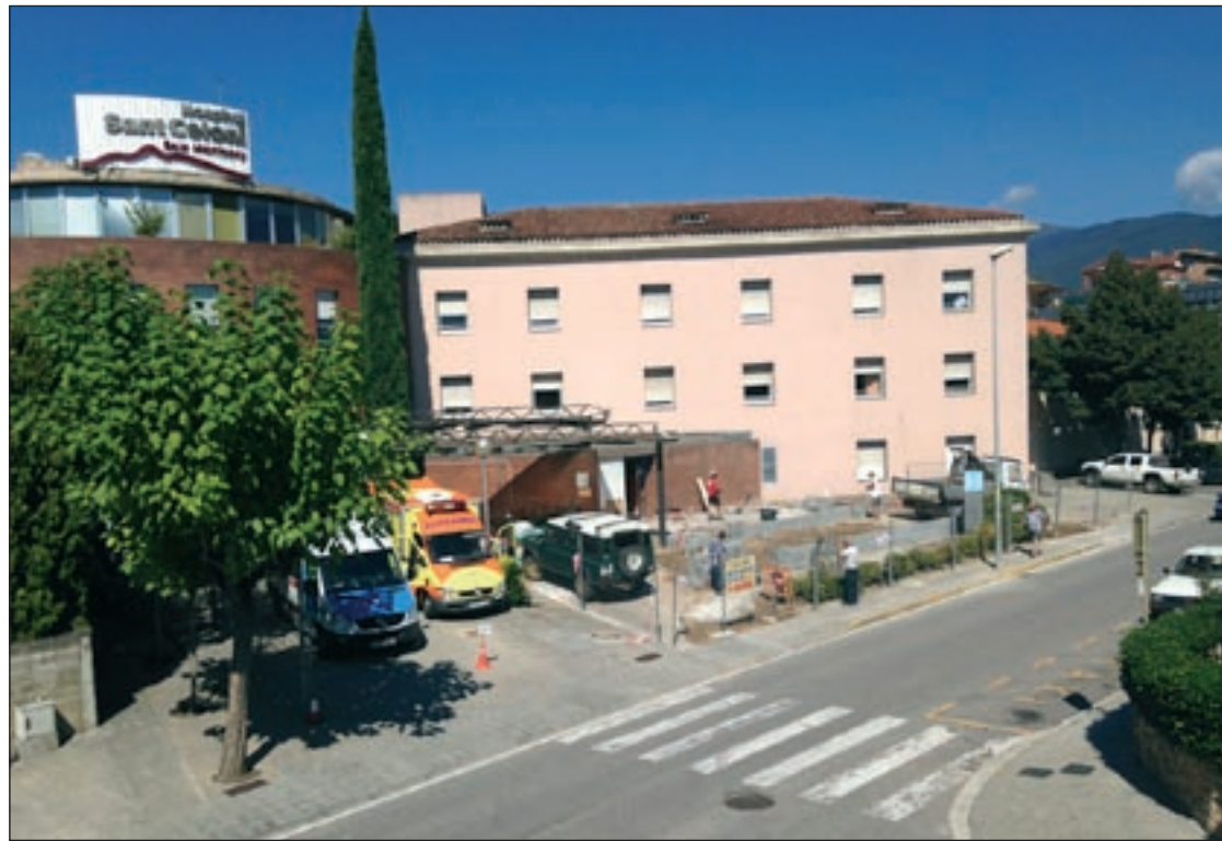
L'accés al servei d'Urgències de l'Hospital de Sant Celoni pel carrer Diputació quedarà afectat per les obres
